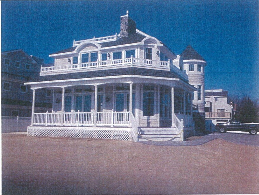
116 Demmy Avenue, Left Side/Front, 04/14/13
